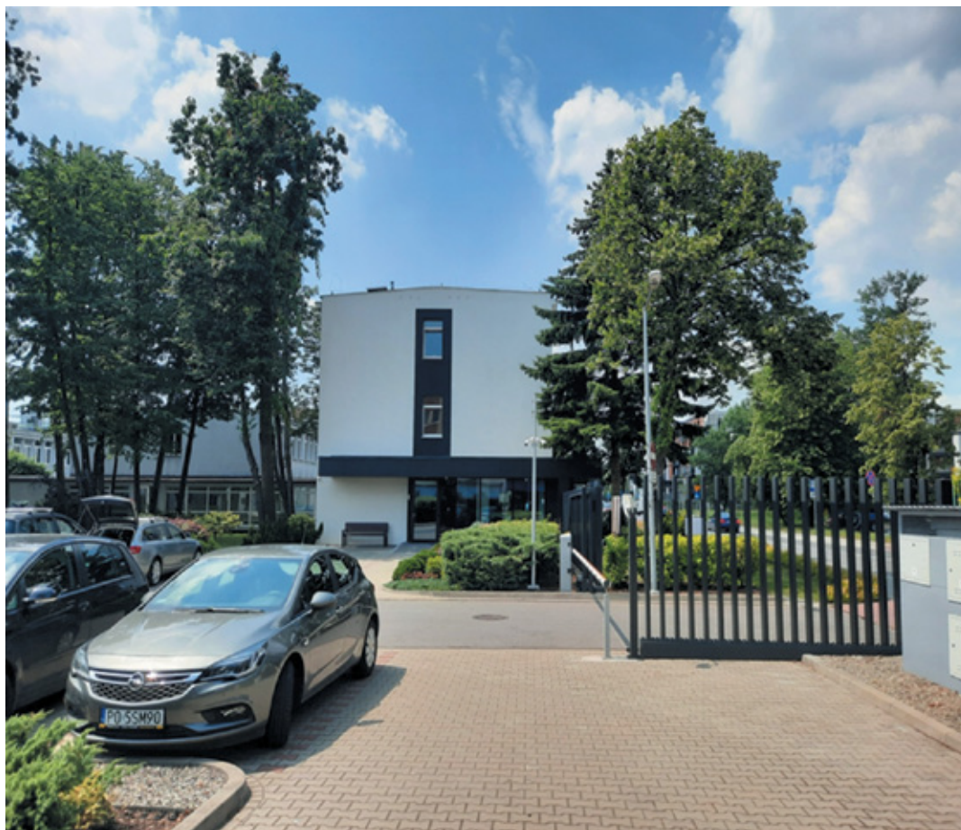
Rys. 17. Budynek INiG – PIB, ul. Bagrowa w Krakowie (źródło: INiG – PIB)
