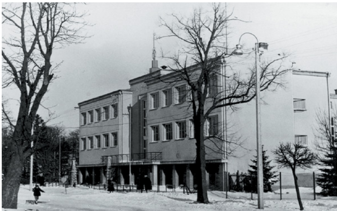
Rys. 10. Dom Robotniczy w Krośnie, siedziba Szkoły Naftowej (Jamróz, 1928; arch. MPNiG w Bóbrce)
